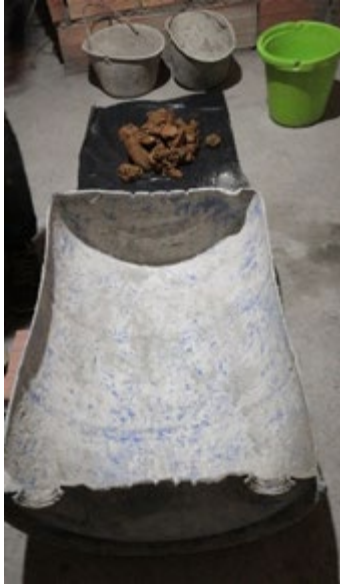
Figura 6. Batea para la realización de las mezclas
