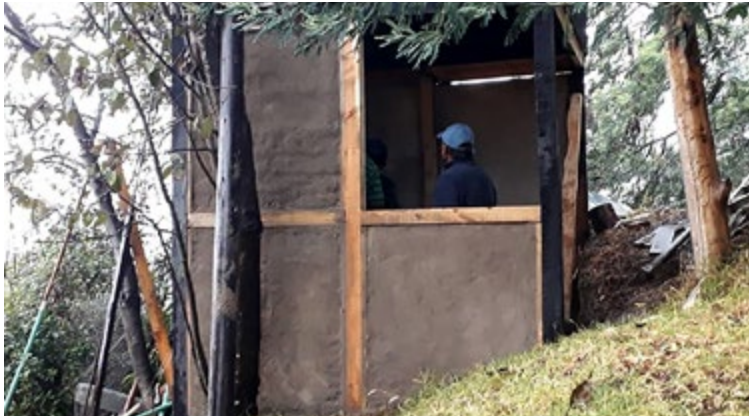
Figura 3. Construcción muro en Bahareque.
