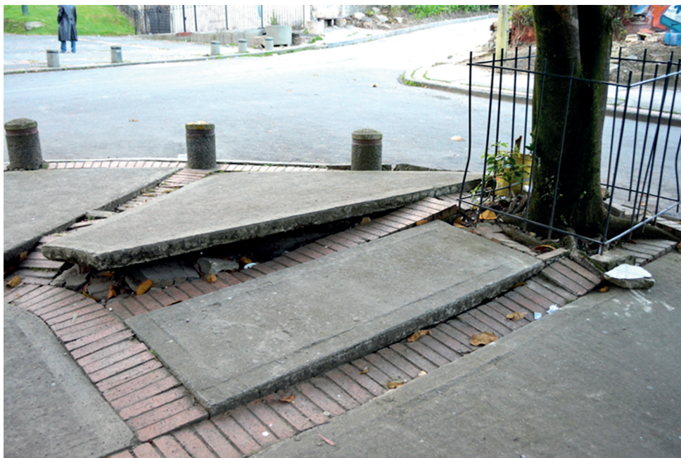
Figura 4. Daños por F. tequendamae . Plazoleta frente a la Quinta de Bolívar. Bogotá. Fuente: elaboración propia.
