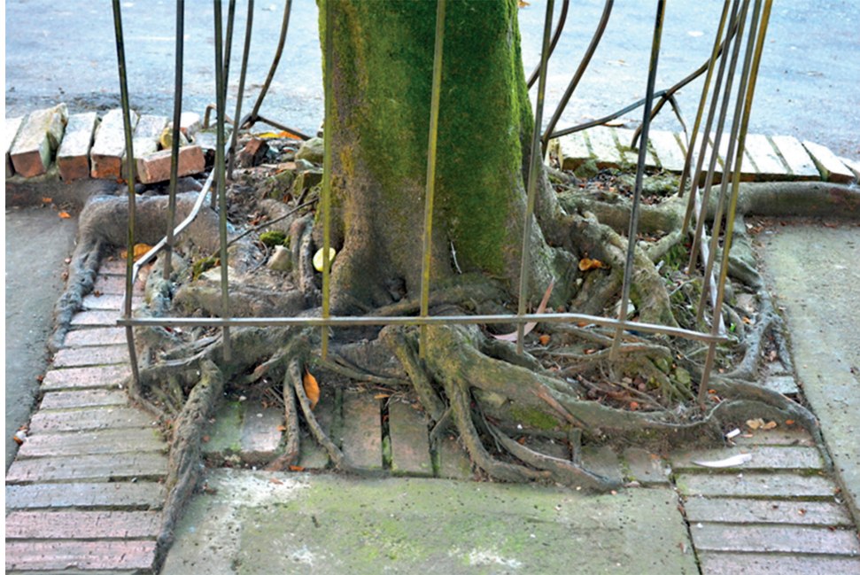
Figura 2. Daños por F. tequendamae . Plazoleta frente a la Quinta de Bolívar. Bogotá. Fuente: elaboración propia.
